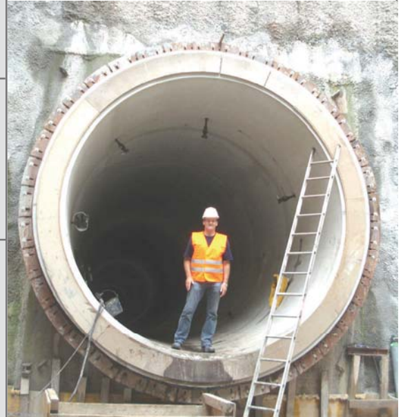
Bild 1: Sicht auf Rücklaufleitung DN 3600 aus Startschacht
